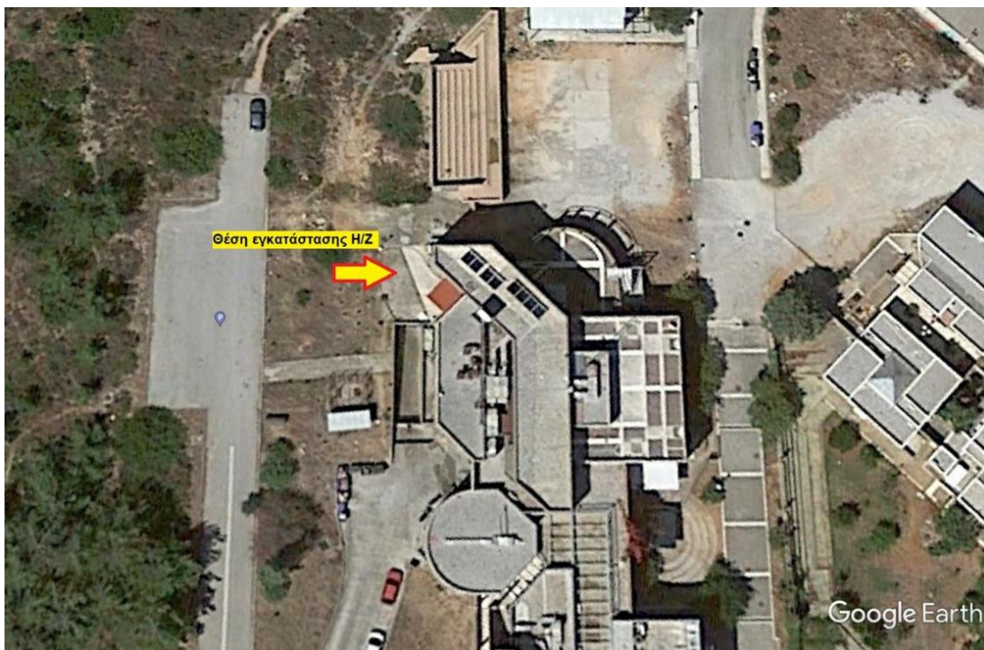
Θέση εγκατάστασης Η/Ζ
