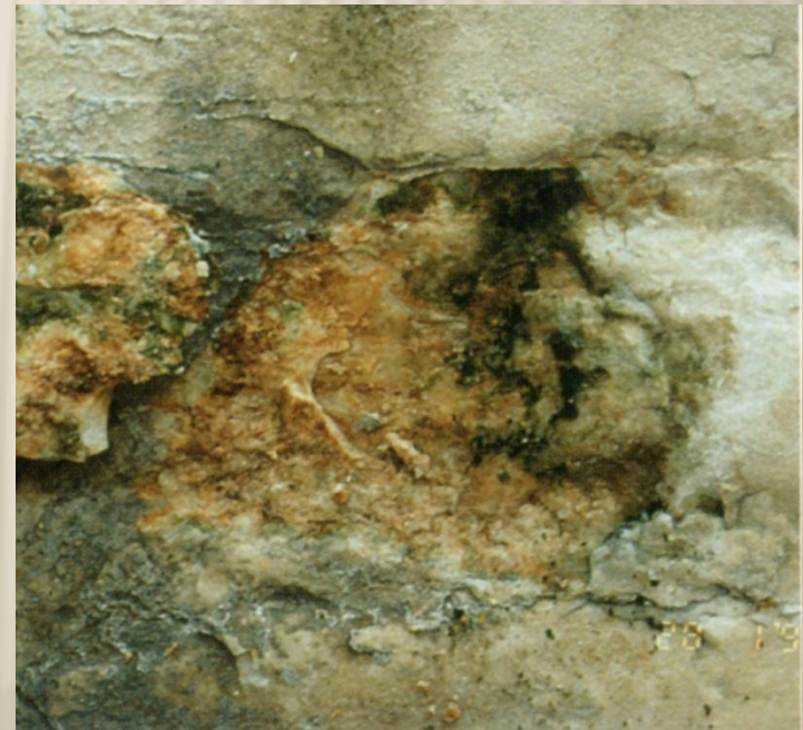
Βιοφθορά των λίθων προέρχεται από τη βιολογική ανάπτυξη μικροοργανισμών
