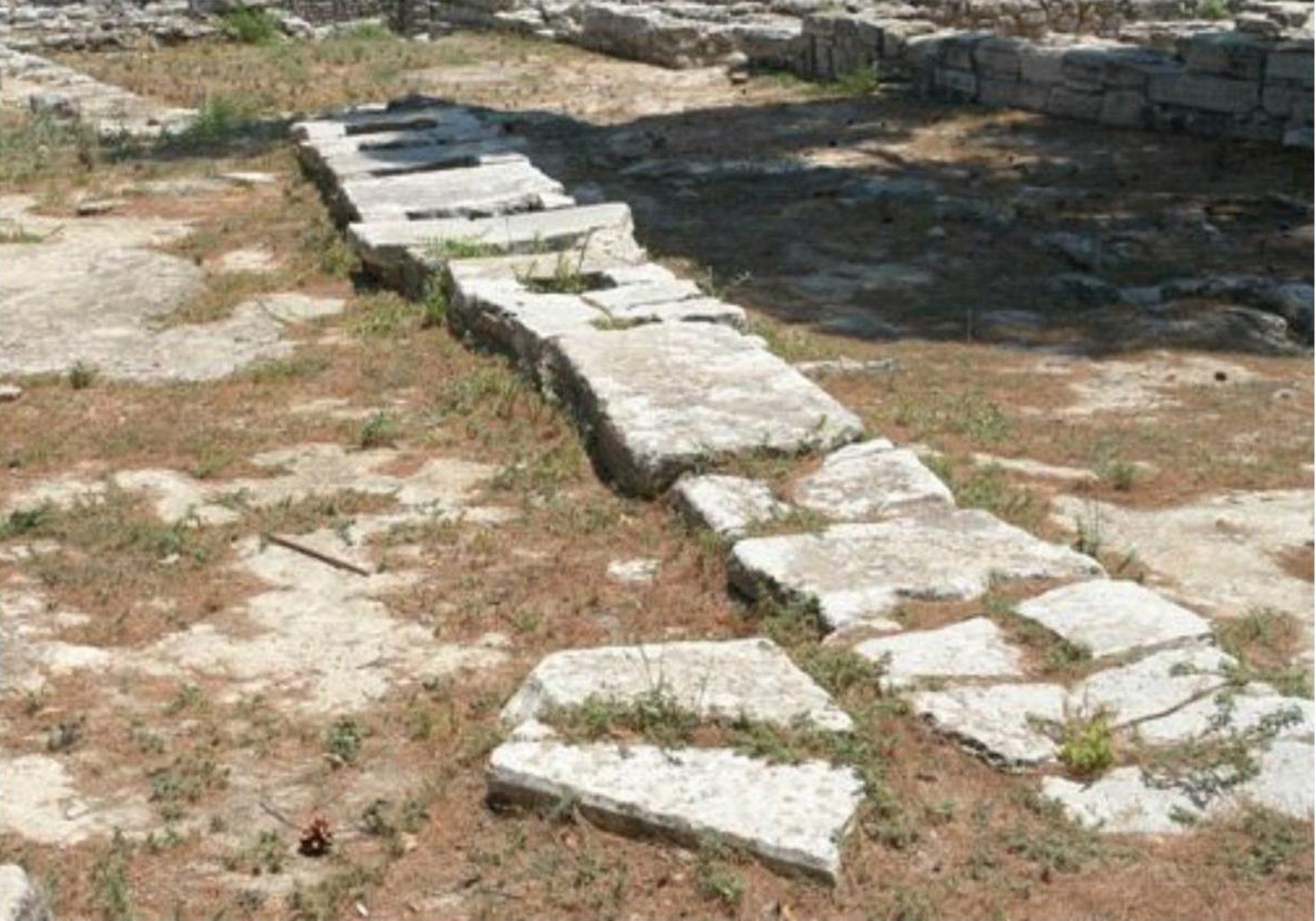
Τμήμα του Μινωϊκού υδραγωγείου Τυλίσσου στην είσοδο του οικισμού
