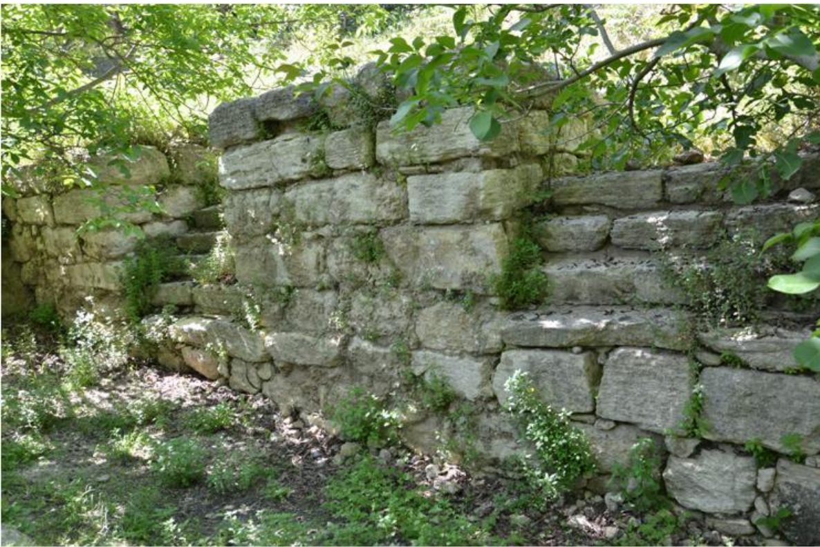
Τμήμα του αρχικού τοίχου της Μινωϊκής οδογέφυρας, που συνέδεε το ανάκτορο με το Caravanseraï
