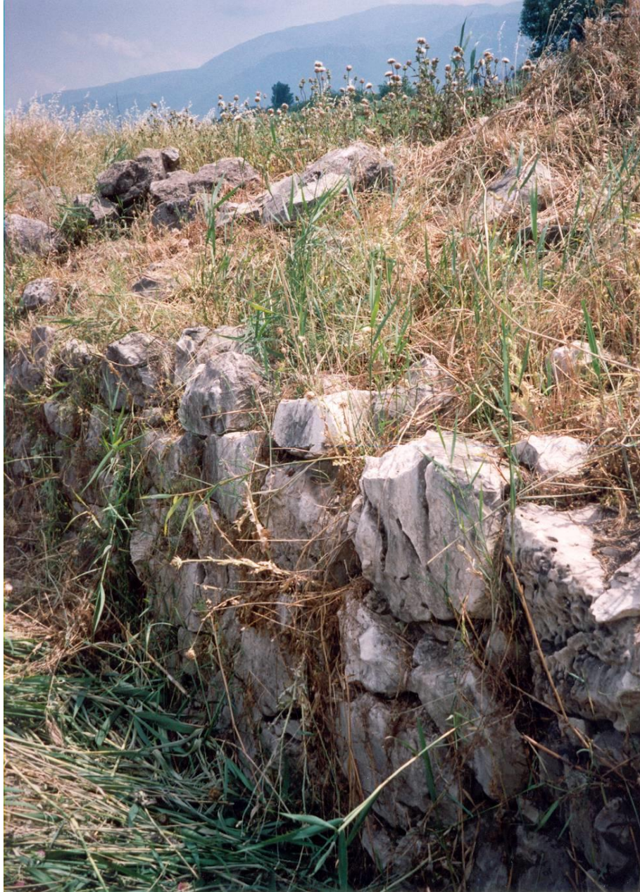
Εικ.1.3. Πρόσωπο από τοιχοποιία στο επίχωμα που διαμορφώνει την εσωτερική πλευρά της αντιπλημμυρικής τάφρου.
